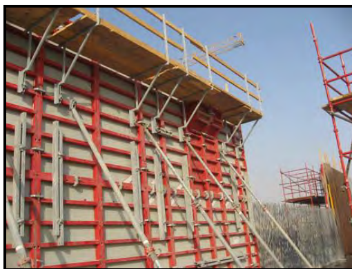
شکل ۱-۵- سیستم قالب‌بندی دیوار بتنی بلند
