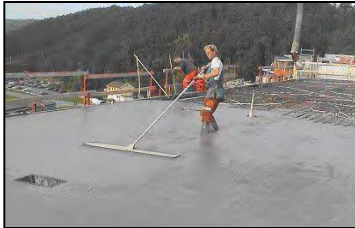
شکل پ.۲-۶- پرداخت سطح بتن خودتراکم
