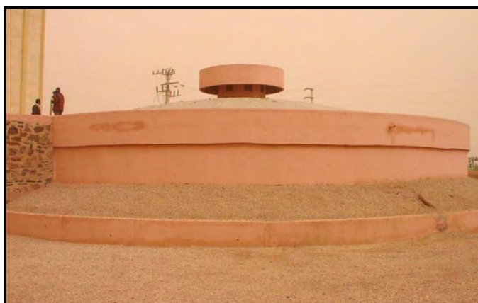
ب- مخزن بتنی زمینی نیمه مدفون
